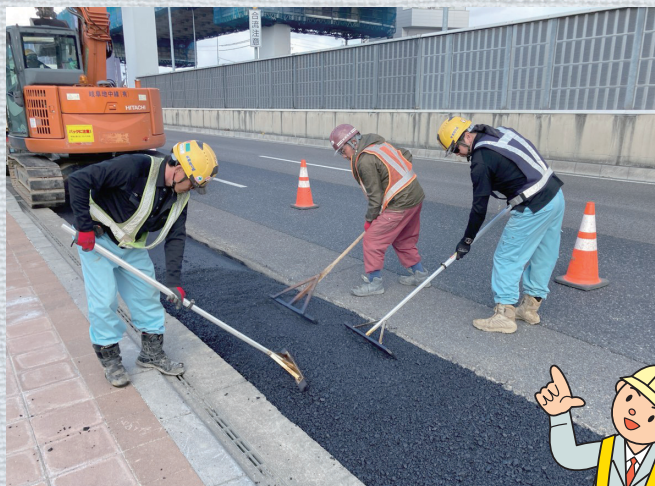
▲アスファルト合材敷き均し状況
