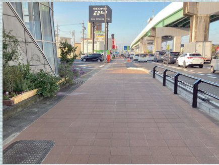
▲歩道整備とガードパイプ設置
