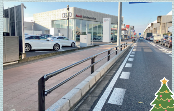
▲ガードパイプ設置
